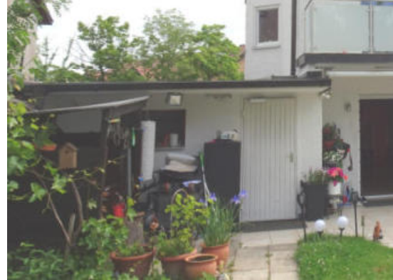
Südwestseite des Garagengebäudes
