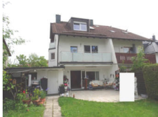
Südwestseite des Gebäudes
