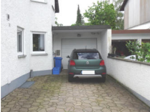
Nordostseite des Garagengebäudes
