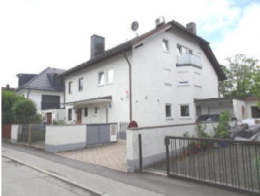
Nordwest- und Nordostseite des Gebäudes
