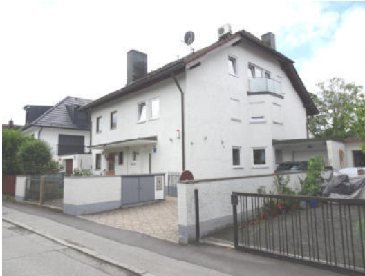
Nordwest- und Nordostseite des Gebäudes
