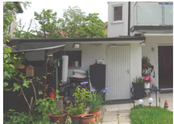
Südwestseite des Garagengebäudes
