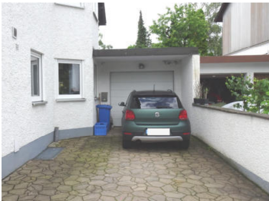
Nordostseite des Garagengebäudes
