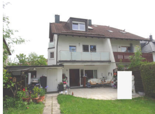
Südwestseite des Gebäudes
