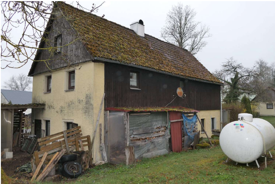
Bild 2: Garten und Giebelseite (Gastank befindet sich auf dem Nachbargrundstück)
