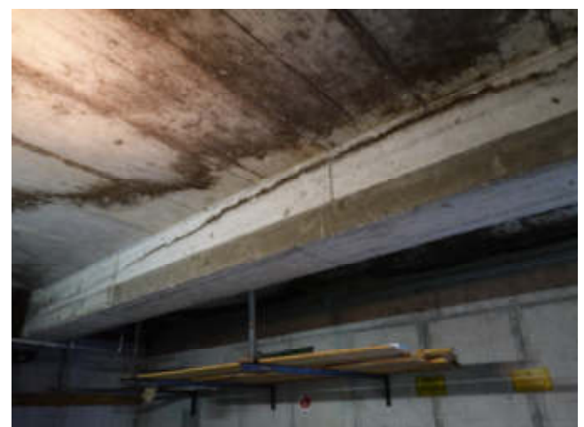
Feuchtigkeitsschäden in der Garage
