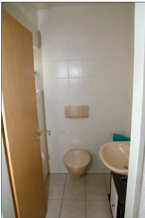
Foto 20 Kellergeschoss - WC im Treppenhaus
