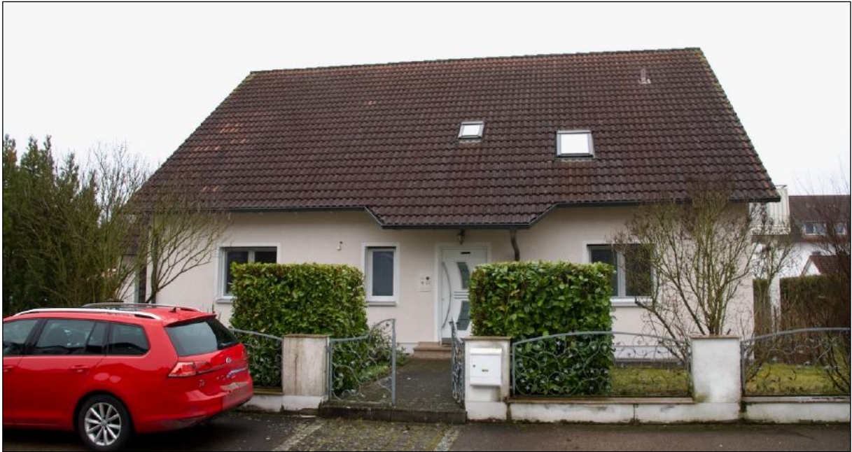
Foto 1 Eingangsansicht von Norden
