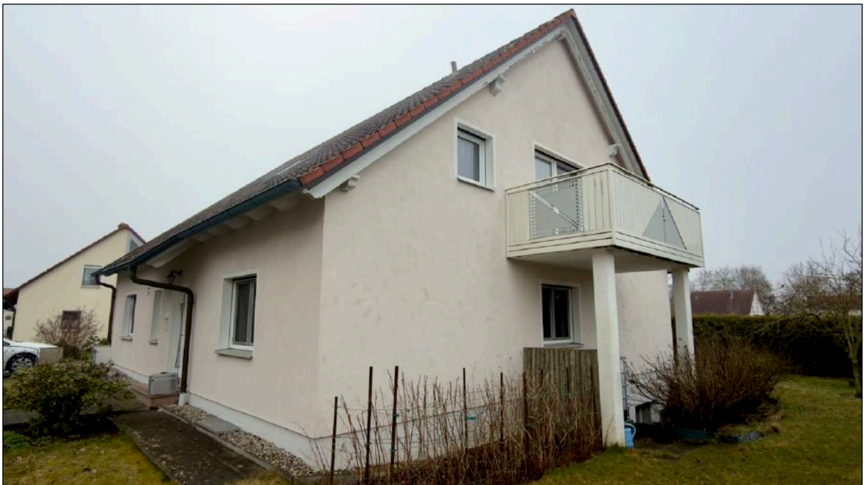
Foto 4 Ansicht von Westen
