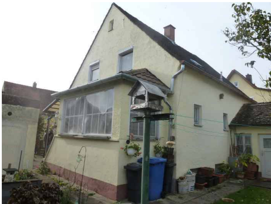
Blick von Nordosten auf das Wohngebäude
