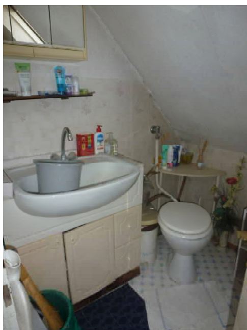
WC im DG
