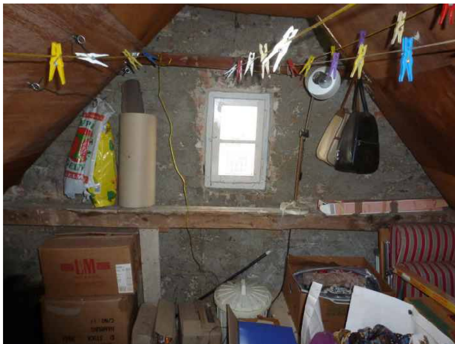
Dachspitz des Wohngebäudes
