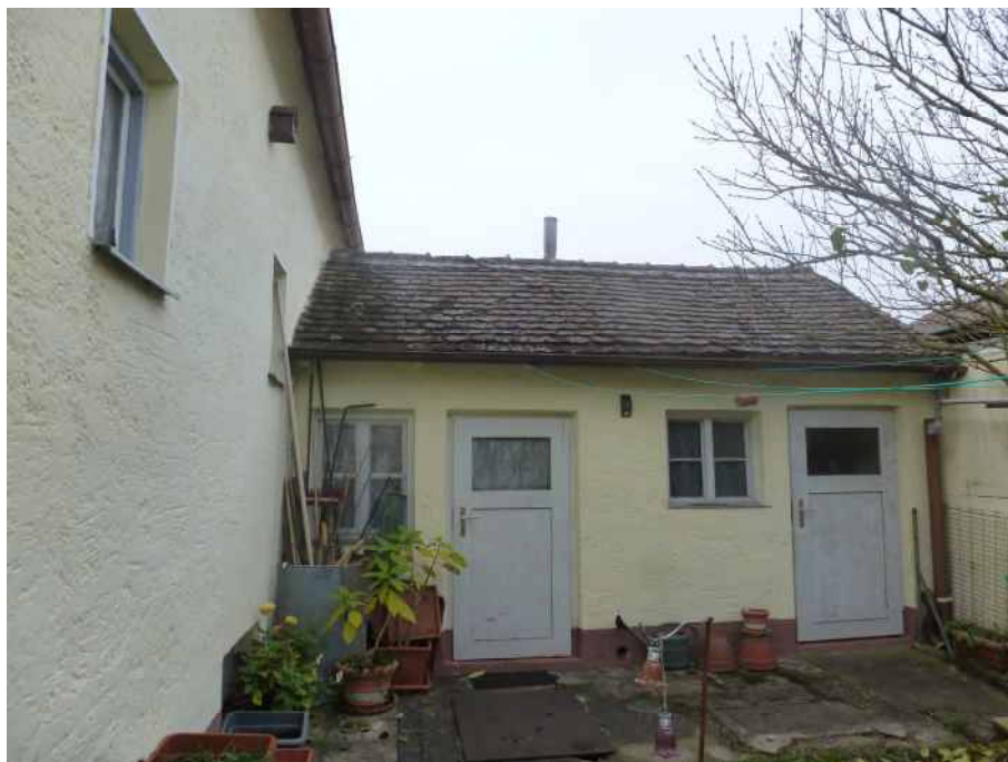
Blick von Osten auf das Nebengebäude
