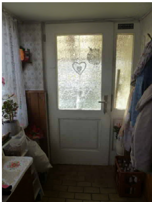
Windfang im EG
