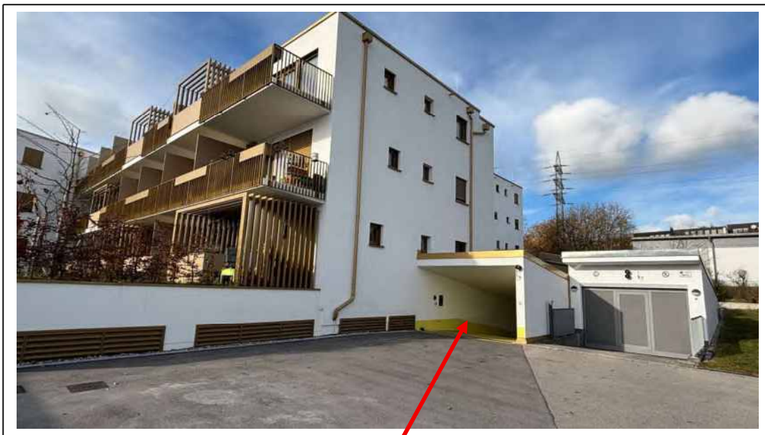
Foto 4: Wohnanlage mit Tiefgaragenzufahrt - Ansicht von Südosten
