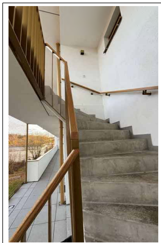
Foto 11: Treppe zum 3. OG
