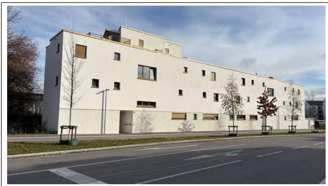
Foto 2: Wohnanlage - Ansicht von Westen
