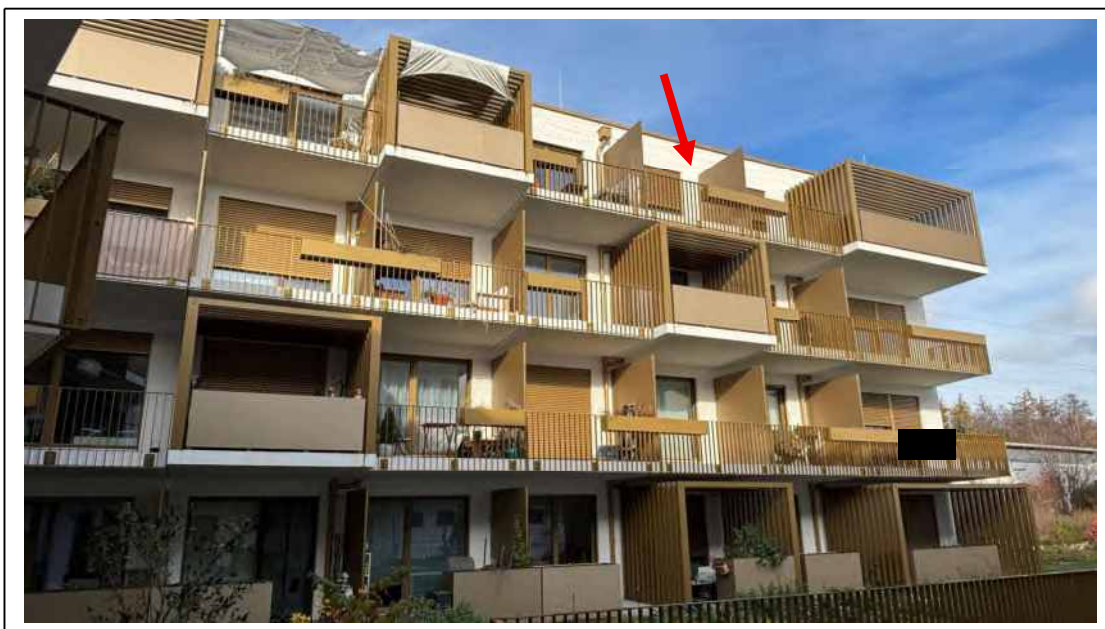
Foto 6: Ansicht von Süden – Blick zum Balkon
