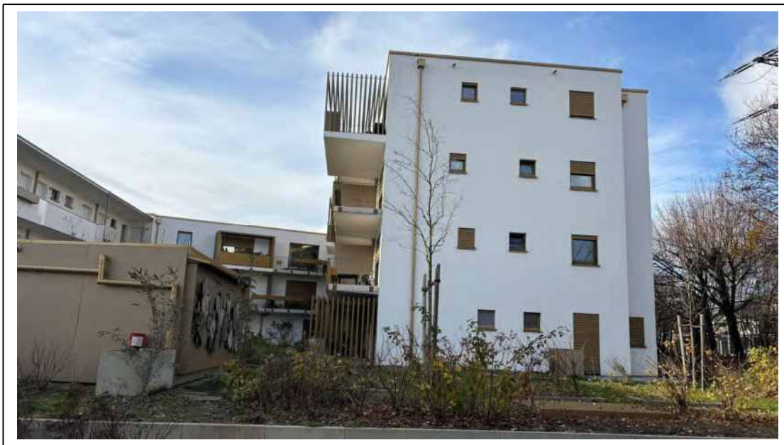
Foto 5: Wohnanlage - Ansicht von Osten
