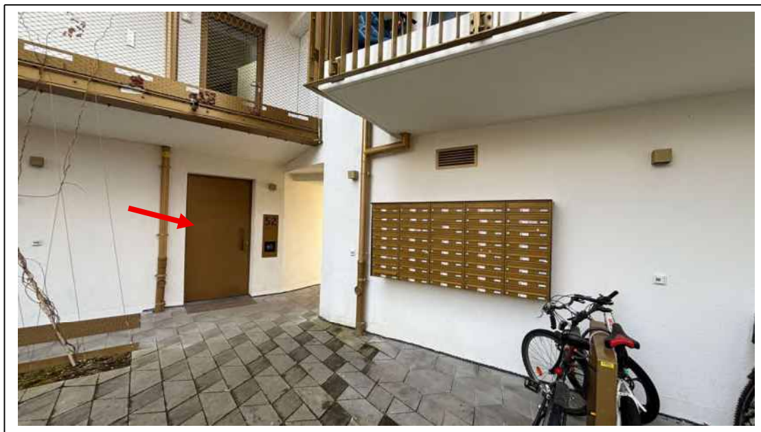
Foto 9: Hauseingangsbereich (Haus Nr. 52)
