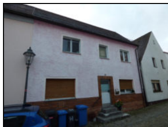
Ansicht EFH von Norden (Zugangsbereich)
