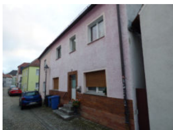
Ansicht EFH von Nordwesten
