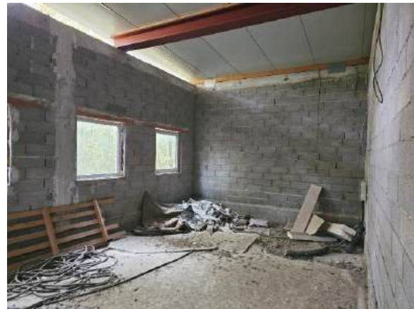
Innenansicht Gebäude/ geplante Betriebsleiter- wohnung
