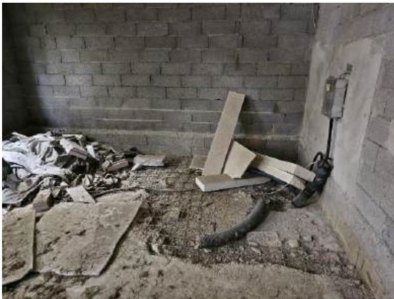
Innenansicht Gebäude/ geplante Betriebsleiter- wohnung
