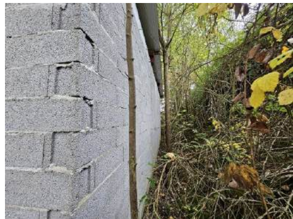
Ansicht Gebäude von Nordwesten mit Abböschung zum Nachbargrundstück Flst. 1881/31
