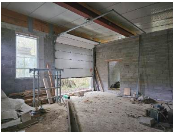
Innenansicht Gebäude/ geplante Werkstatt
