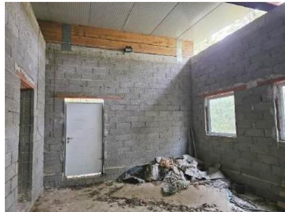
Innenansicht Gebäude/ geplante Betriebsleiter- wohnung
