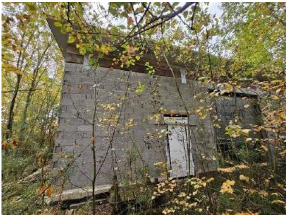
Ansicht Gebäude von Norden
