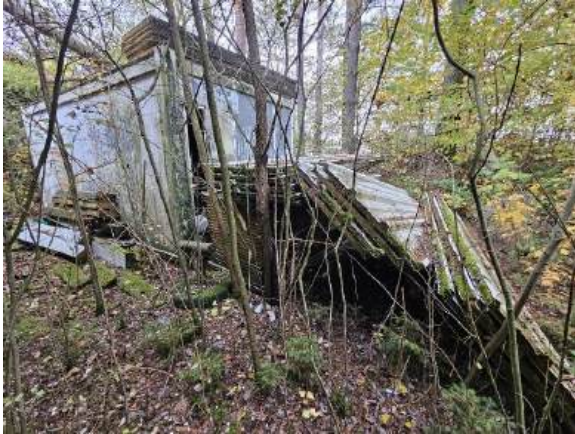
Container und Baumaterial nördlich vom Gebäude
