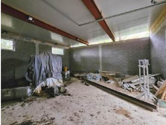
Innenansicht Gebäude/ geplante Werkstatt
