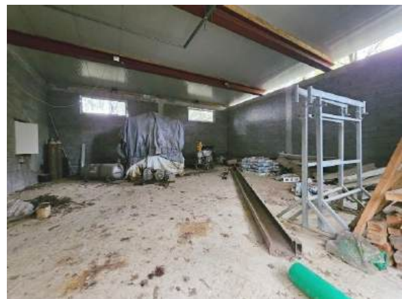
Innenansicht Gebäude/ geplante Werkstatt
