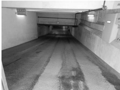
Rampe Tiefgarage Ein-/Ausfahrt
