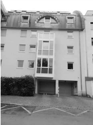
Ansicht Nordfassade Dr.-Mack-Straße 34, Tiefgarage Ein-/Ausfahrt
