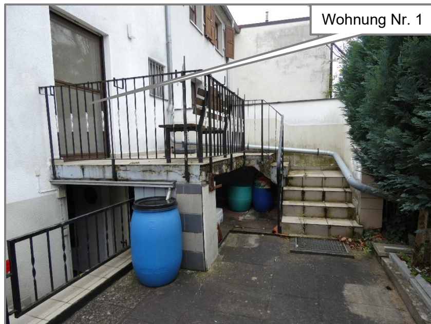
Außenbereich an der Nordwestfassade des Zweifamilien-Reihenendhauses - Blick nach Westen zur Kelleraußentreppe und der Terrasse
