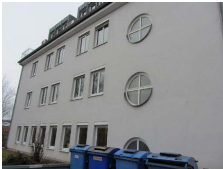
Bild 3: Ansicht Ost (hinterer Gebäudeteil)
