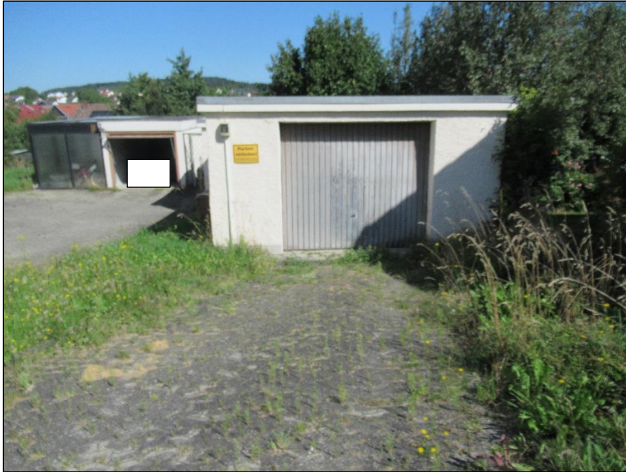
Garage Ansicht - Süden
