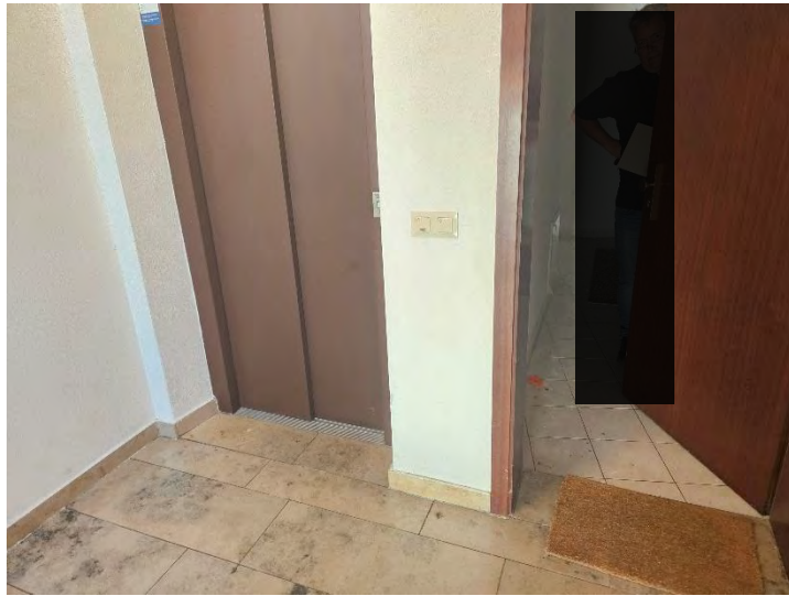
Treppenhaus mit Aufzugsanlage Wohnungseingang zu SE-Nr. 1
