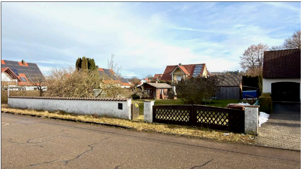
Foto 2 Ansicht von Westen
