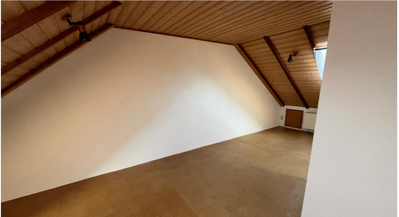
Blick in das Dachgeschoss
