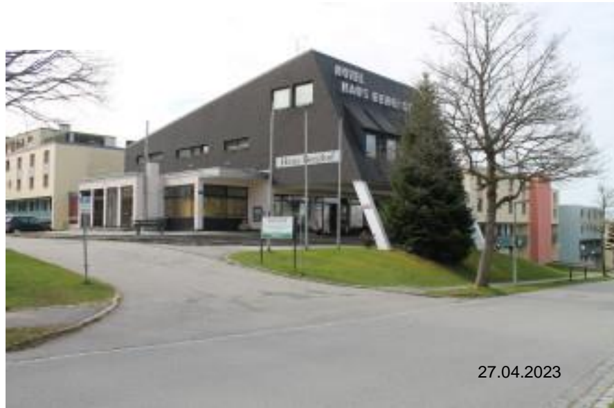
Bild 1: App. 133 – Haus Berghof Ansicht Eingang / Rezeption von Norden
