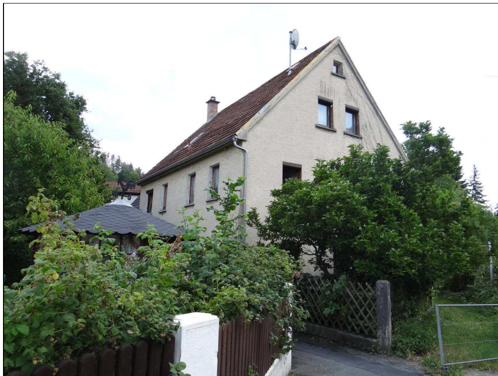
Bild 1: Blick auf das Wohngebäude von Süd-Westen
