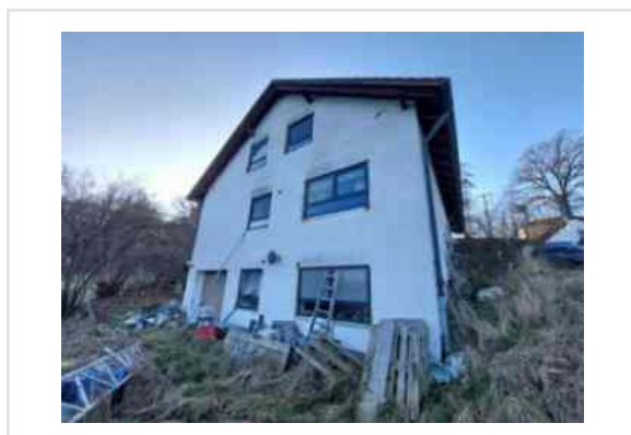
Seitenansicht links, Garage
