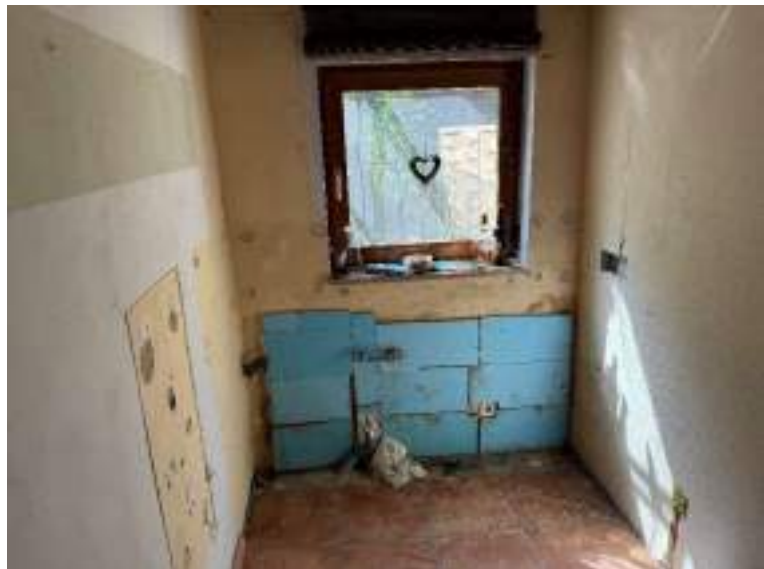
Nicht fertiggestellte Umbaumaßnahme Küche EG
