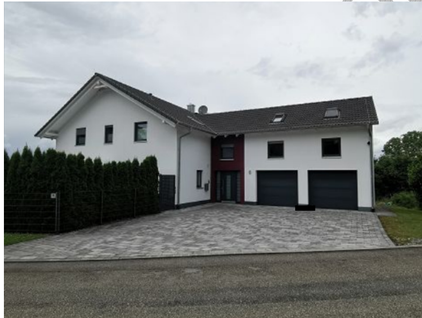
Ansicht von Süden, Quelle: eigenes Datenmaterial
