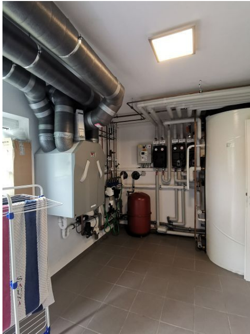
KG Waschküche und Heizraum
