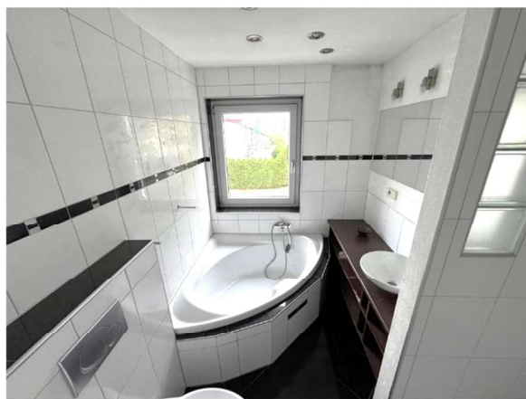
Reihenmittelhaus 1. Obergeschoss Bad
