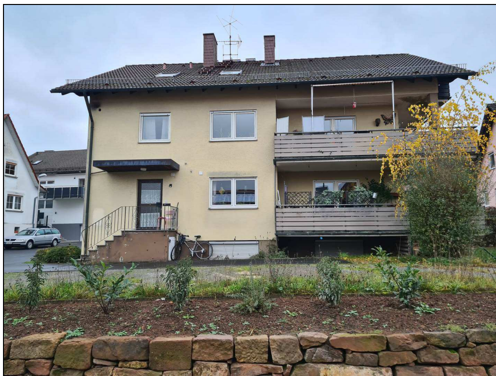
Bild 4: West-Ansicht des Wohngebäudes
