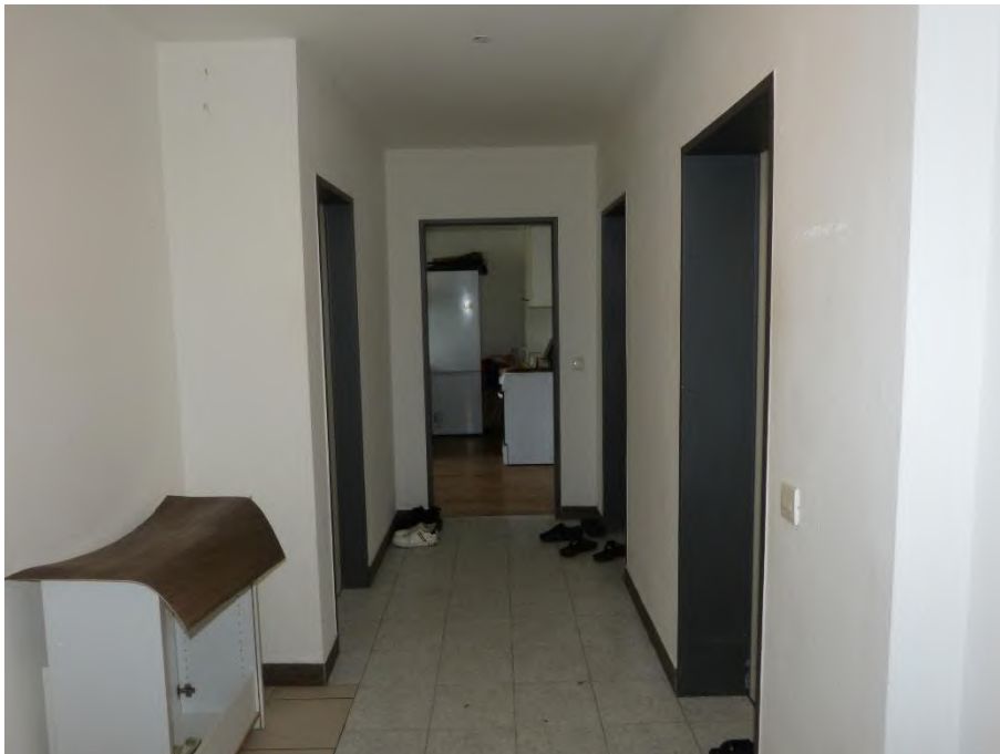
Wohnungseigentum Nr. 2, Innenaufnahme Flur im Erdgeschoss
