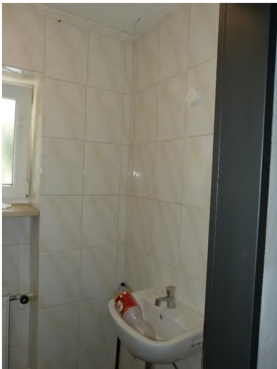
Wohnungseigentum Nr. 2, Innenaufnahme WC im Erdgeschoss
