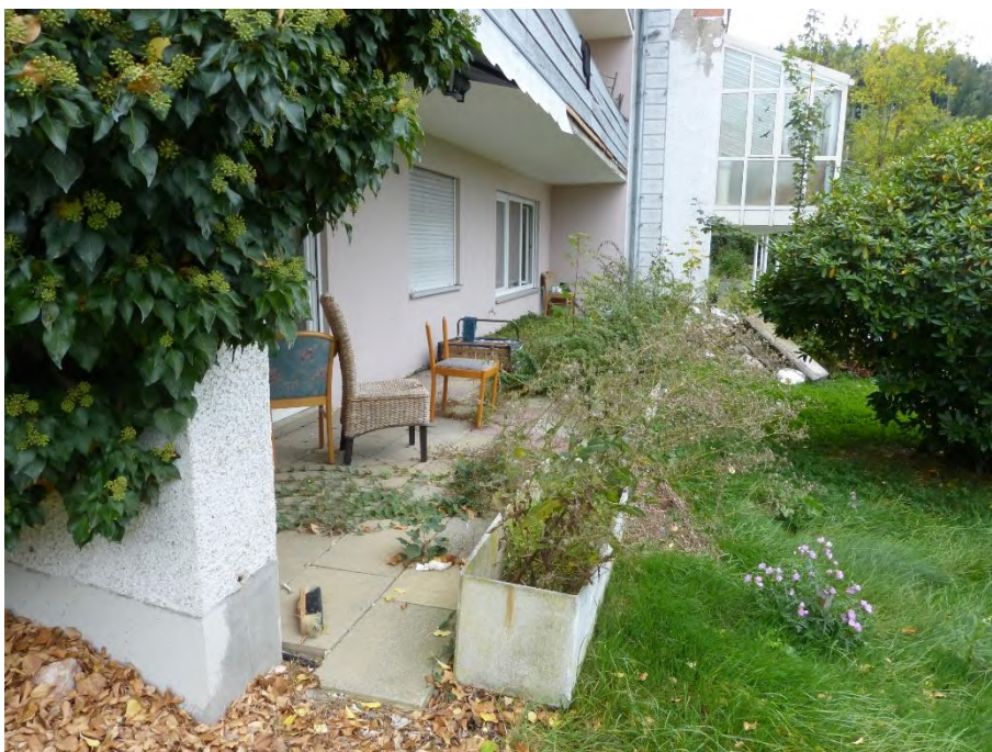
Wohnungseigentum Nr. 2, Teilansicht Terrasse im Untergeschoss
