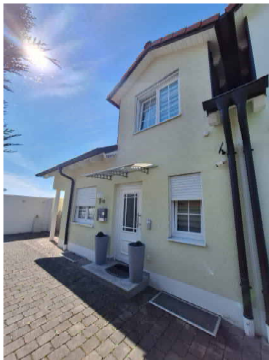
Blick von Nordwesten auf das Wohngebäude
