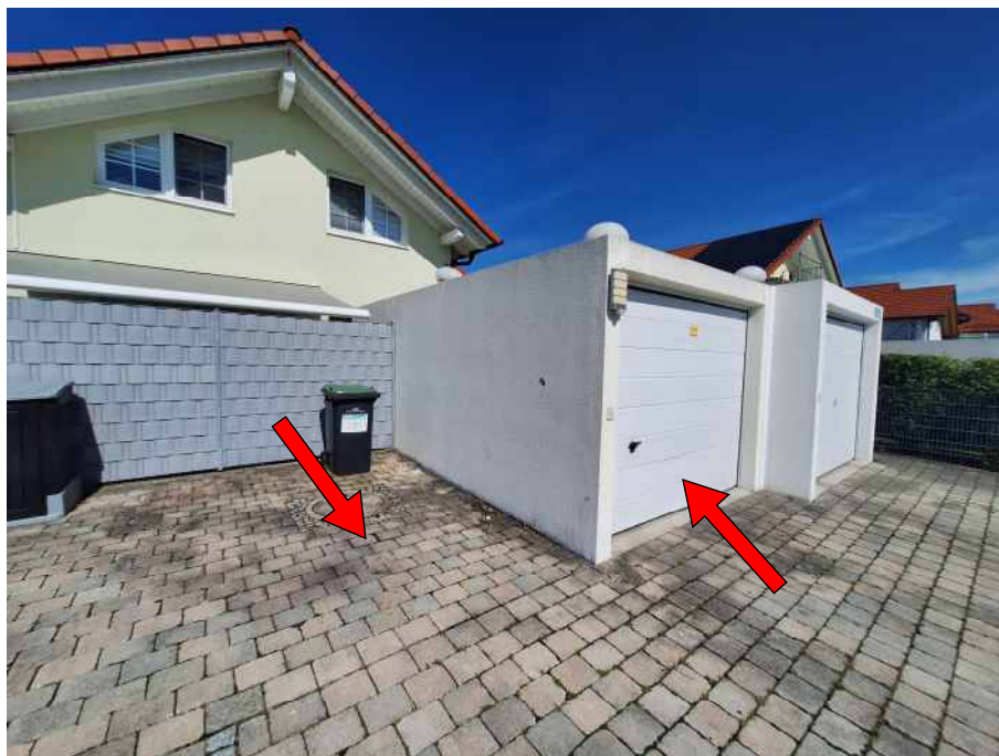
Blick von Südosten auf den Außenstellplatz und die Garage
