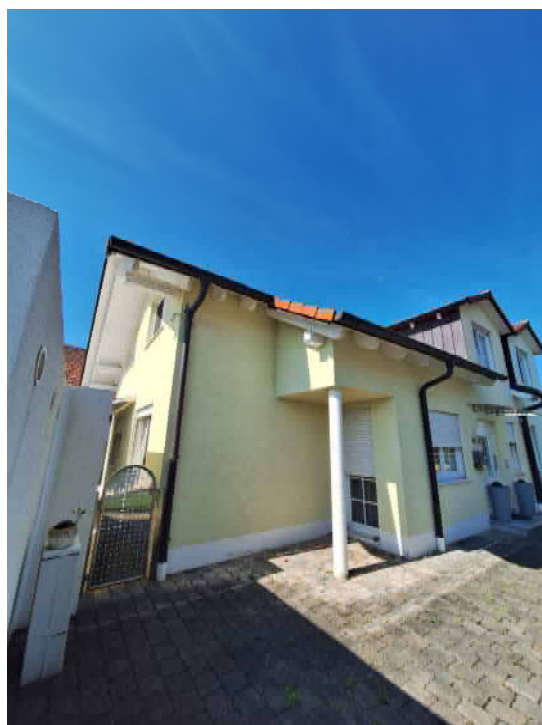
Blick von Nordosten auf das Wohngebäude
