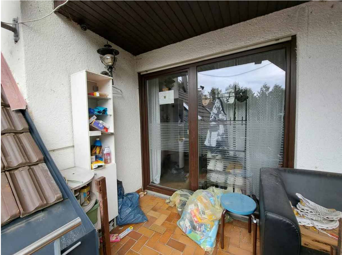
25 Hauptzugang Wohnung Nr. 2 über Balkon
