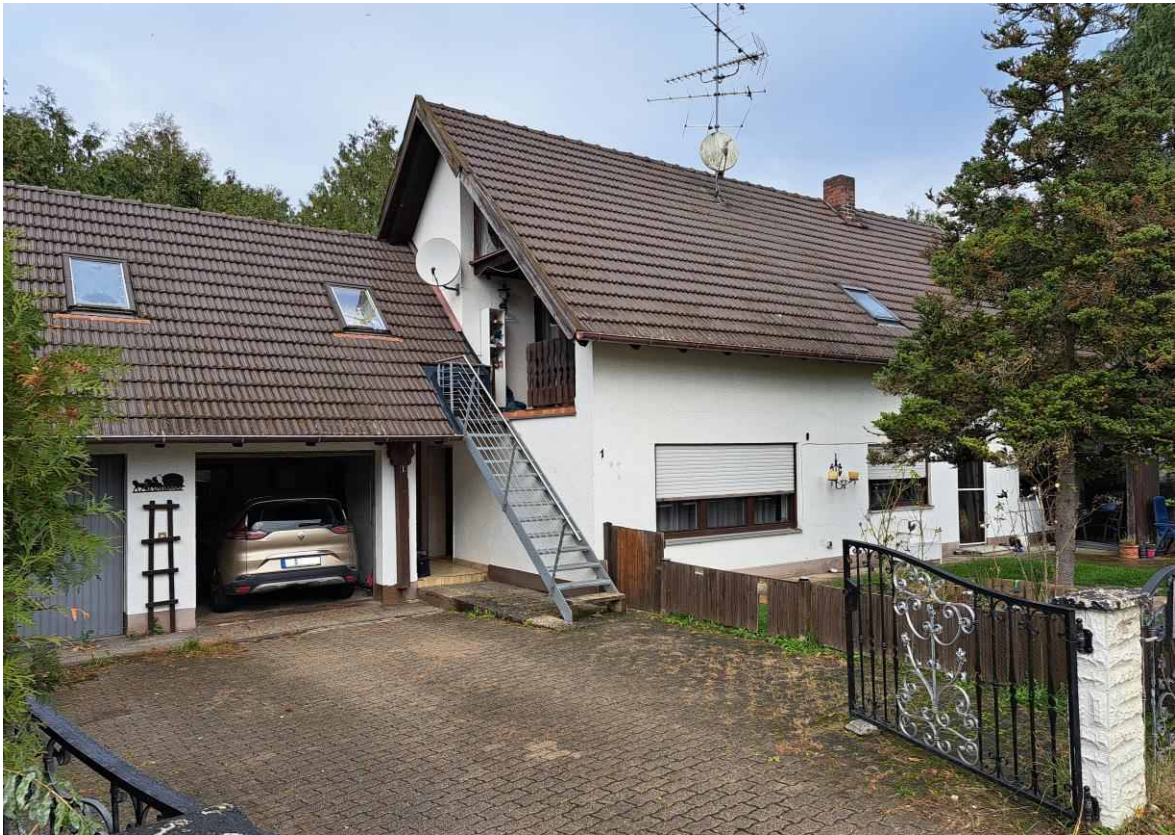
1 Außenansicht Südwest und Südost
