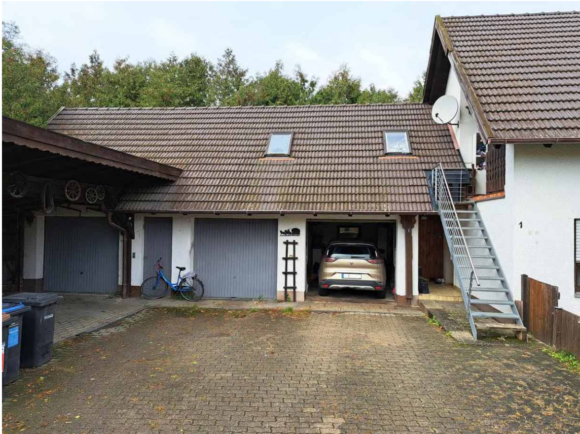
7 Garagenanbau und Außentreppe zum Eingang der Wohnung Nr. 2 im DG
