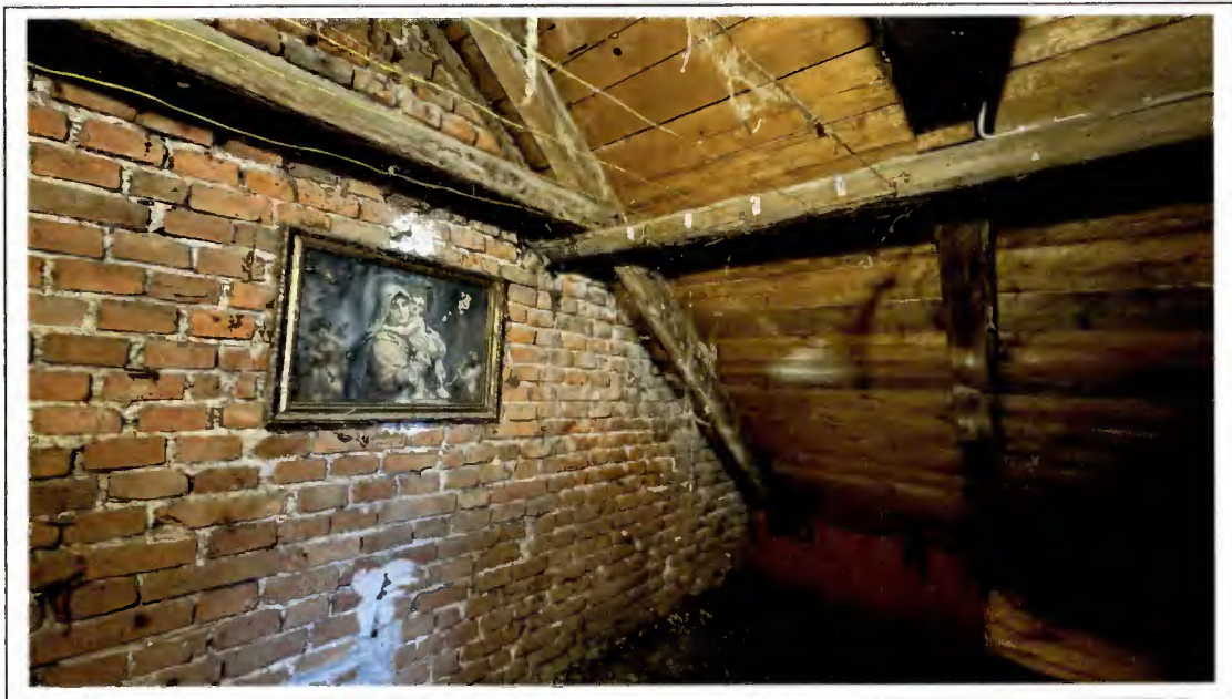
Foto 25: Blick in das Dachgeschoss (Hauptgebäude)
