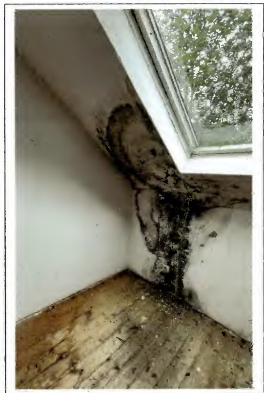
Foto 23: Schimmelspuren
