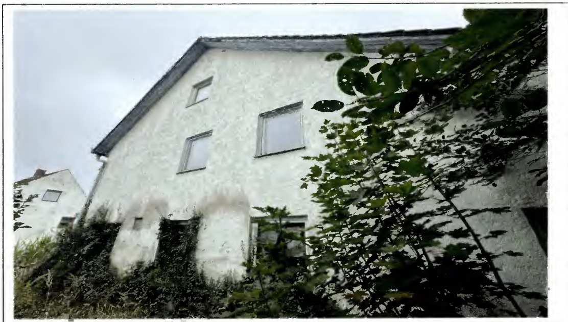
Foto 4: Ansicht von Nordosten
