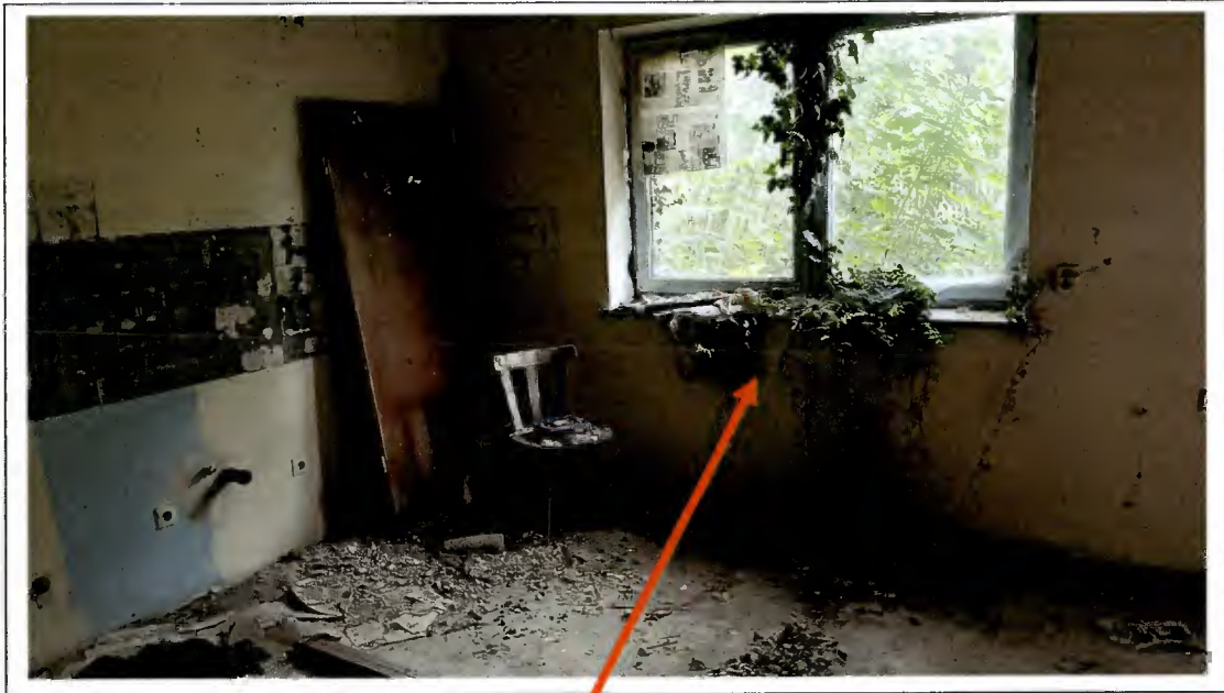
Foto 12: Blick in die Küche; Efeu-Bewuchs aus dem Garten
