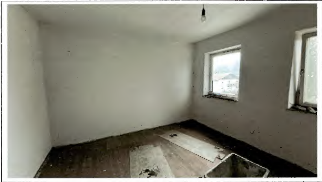
Foto 20: Blick in einen OG-Raum
