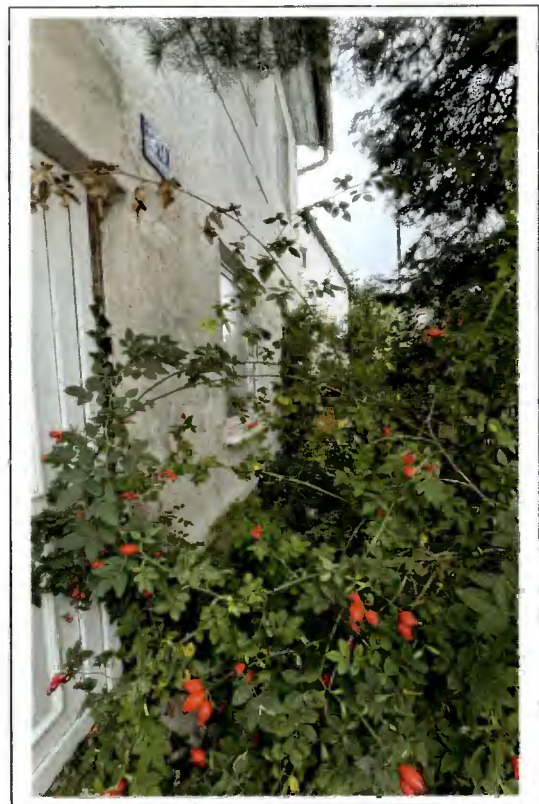
Foto 9: südliche Fassade, Vorgarten
