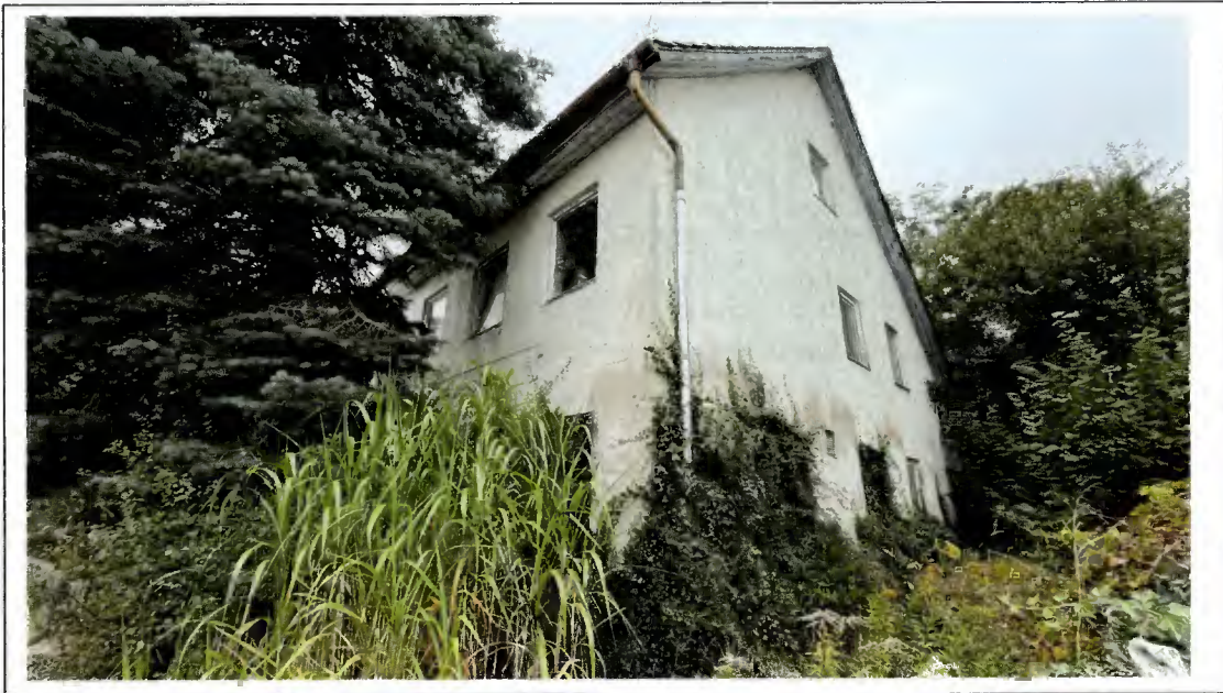
Foto 3: Ansicht von Südosten
