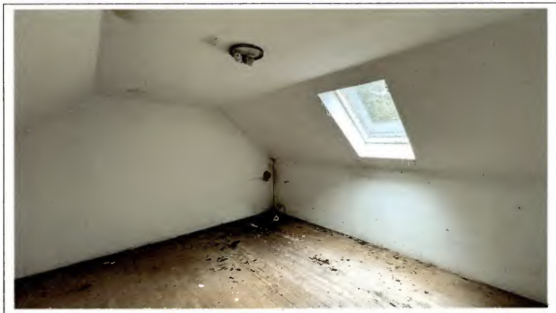
Foto 24: Blick in einen DG-Raum im Anbau 2
