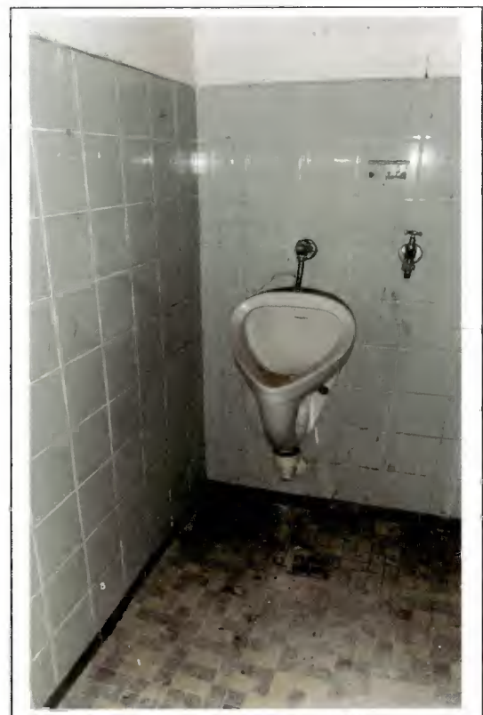
Foto 15: Sanitäre Anlagen im EG
