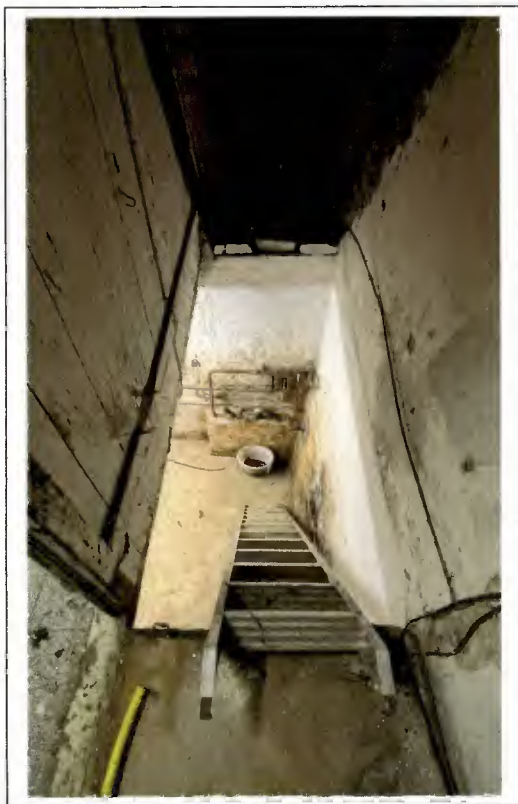
Foto 26: Zugang zum Kellerraum
