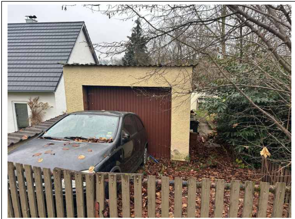
Foto 6: Garage – Ansicht von Süden
