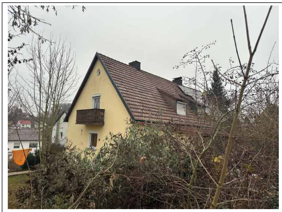
Foto 1: Ansicht von Südwesten
