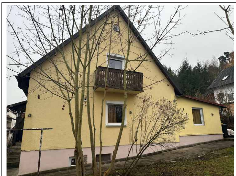
Foto 2: Ansicht von Westen
