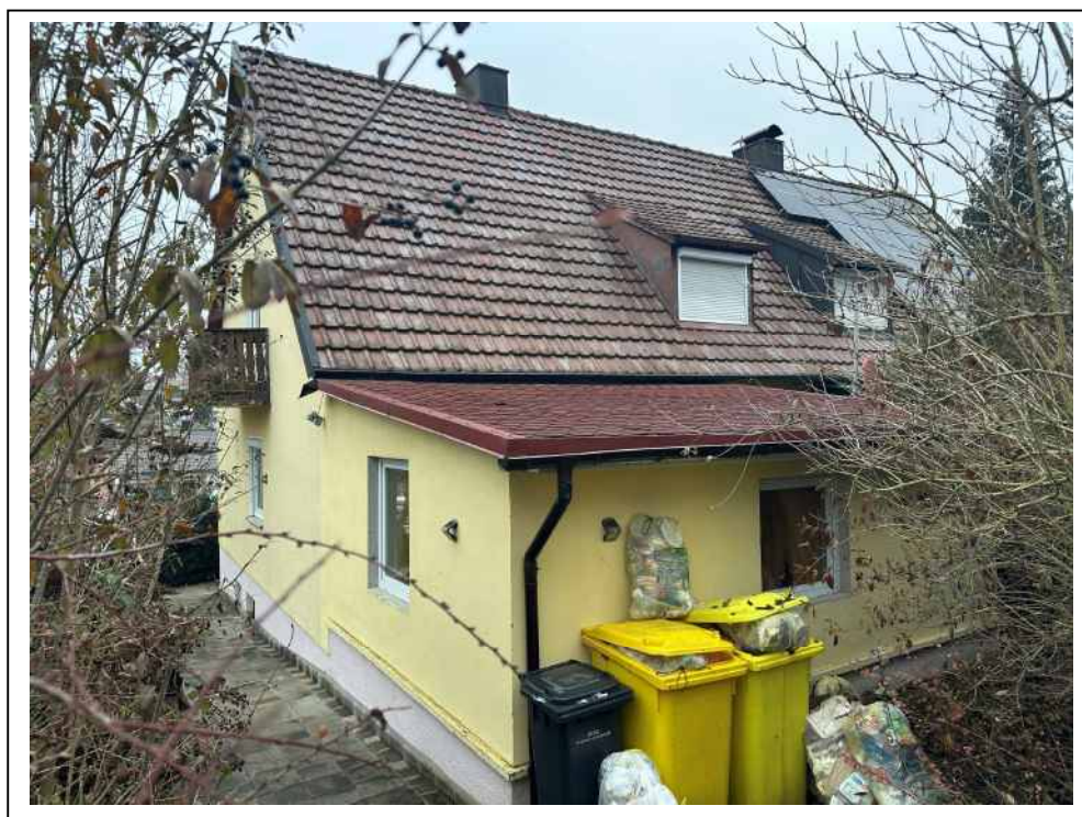
Foto 3: Ansicht von Südwesten
