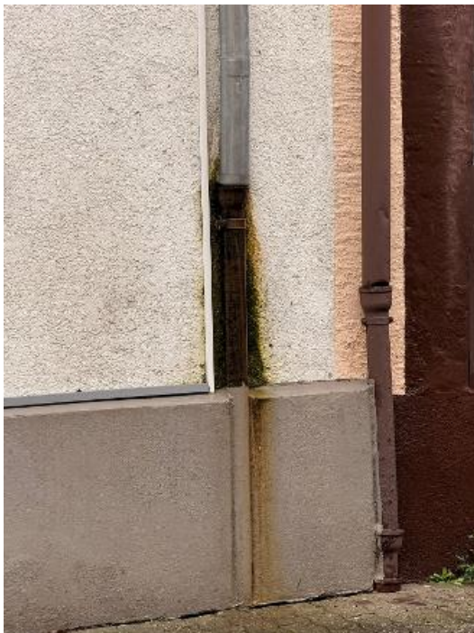
Beschädigtes Fallrohr
