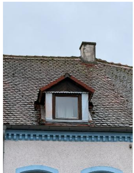
Dachgaube mit Holzrahmen-Fenster
