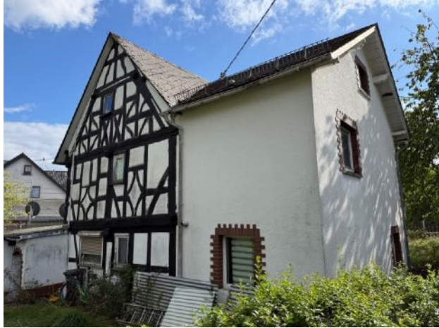
rückwärtige Ansicht und Seitenansicht
