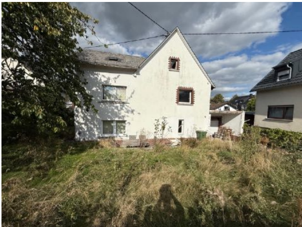
vorderer Grundstücksbereich und das Gebäude
