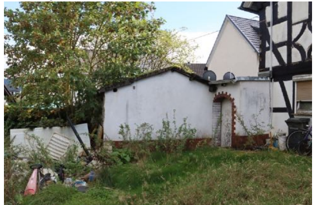
Nebengebäude, hinterer Grundstücksbereich
