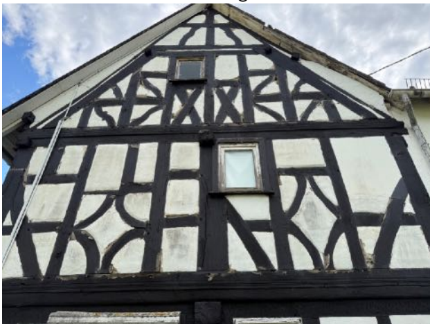
Teilansichten der rückwärtigen Ansicht
