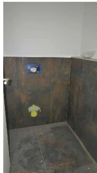
Bild 24: Innenansicht Ober- geschoss Bürobereich
