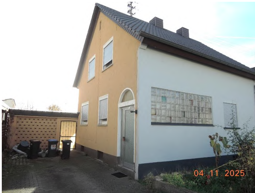
Bild 1: Straßenansicht aus nordöstlicher Richtung
