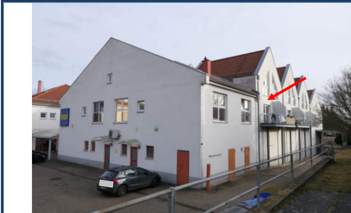
Abbildung 1: Seiten-Rückansicht (Süd-West-Ansicht; Baukörper A); Außenanlagen; Lage des zu bewertenden Wohnungseigentums Nr. 9
