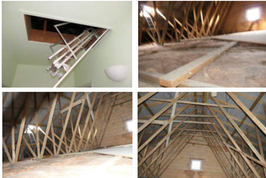
Abbildung 21: Dachboden (eingeschränkt nutzbar durch fehlenden Bodenbelag)
