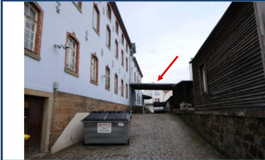
Abbildung 35: Blick von der Bergstraße zum Bewertungsobjekt; umliegende Bebauung und Nutzung
