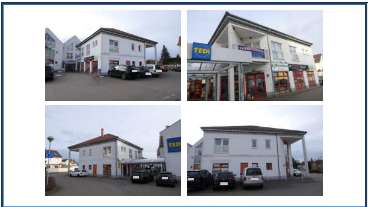
Abbildung 26: Baukörper B - Detailansichten
