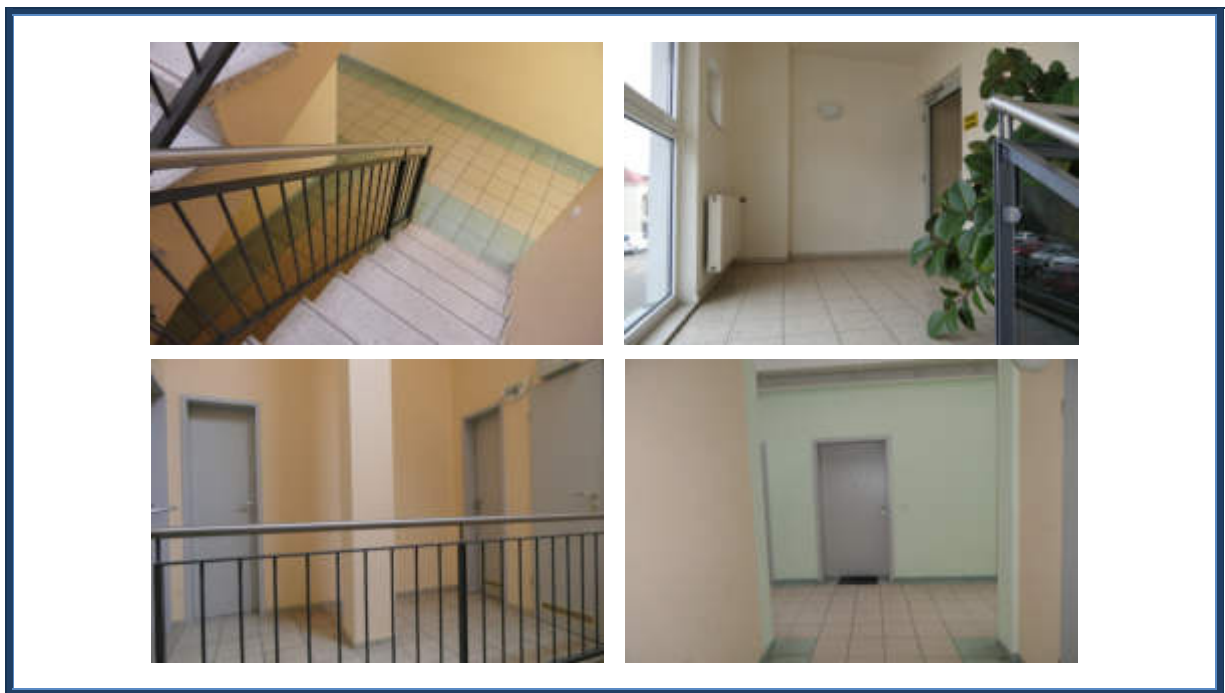
Abbildung 7: Hausflur und Treppenhaus; Zugang zum Abstellraum Nr. 9
