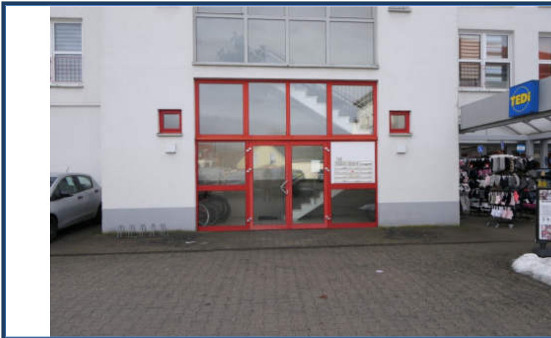
Abbildung 5: Eingangsbereichs zu dem zu bewertenden Wohnungseigentum Nr. 9; Außenanlagen
