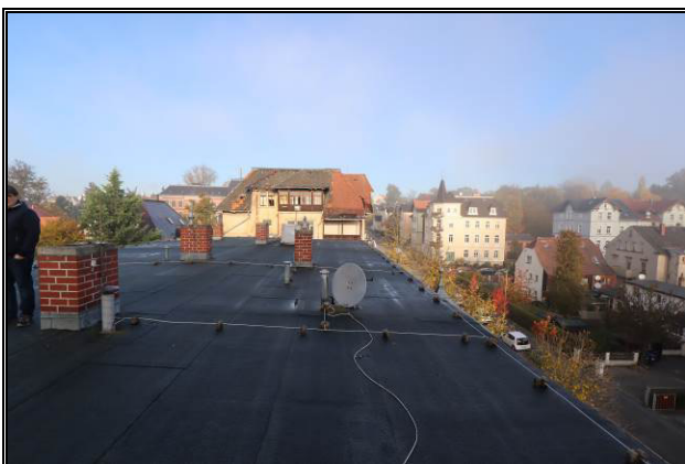
Flachdachbereich des Bewertungsobjekts
