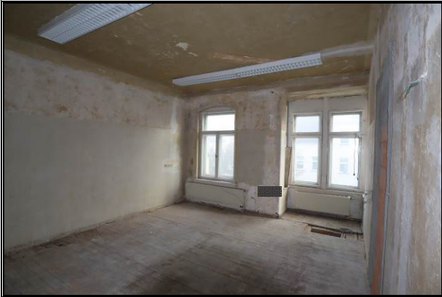
Raum im OG im Rohbauzustand
