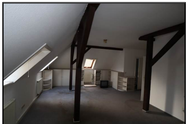
Teil des Dachgeschosses
