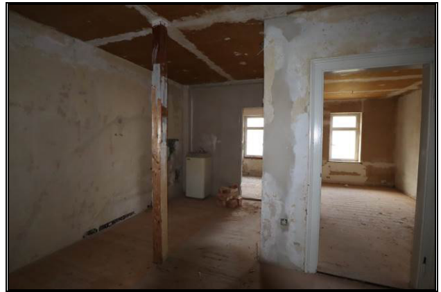
Raum im OG im Rohbauzustand
