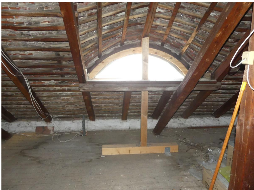
Foto 20: Dachboden mit Fledermausgaube
