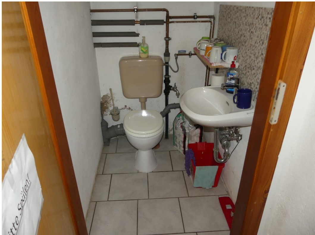
Foto 11: WC im Keller
