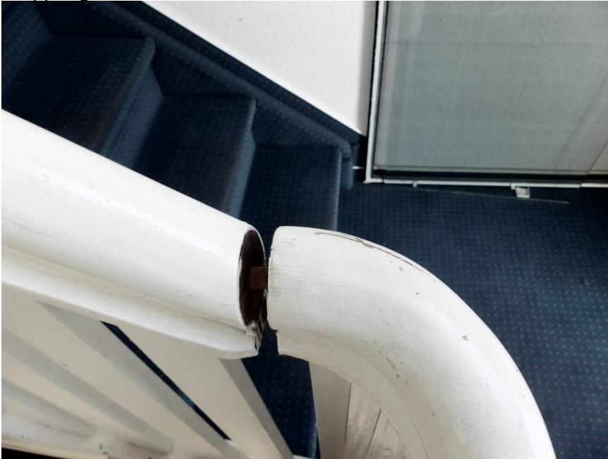
Treppengeländer defekt
