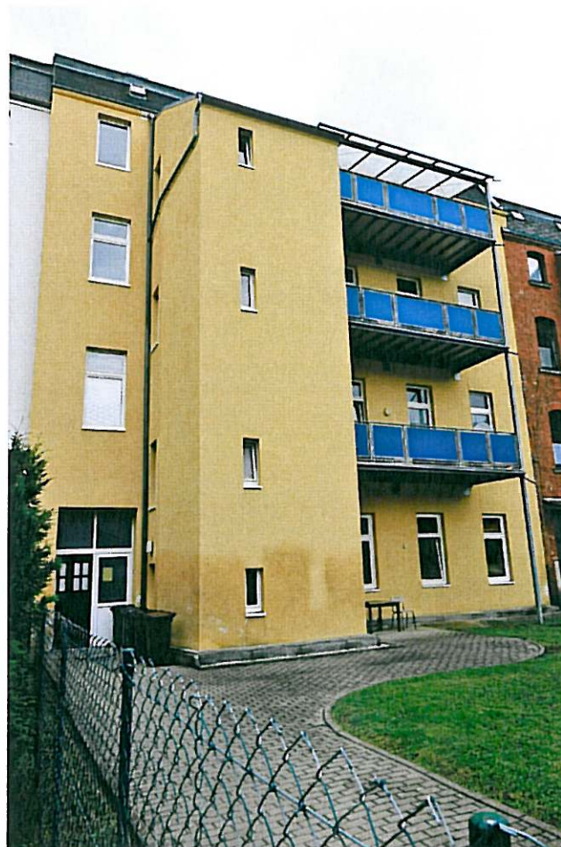
Wohn-/Geschäftshaus (südwestlicher Bereich) mit Hauszugang, Südansicht
