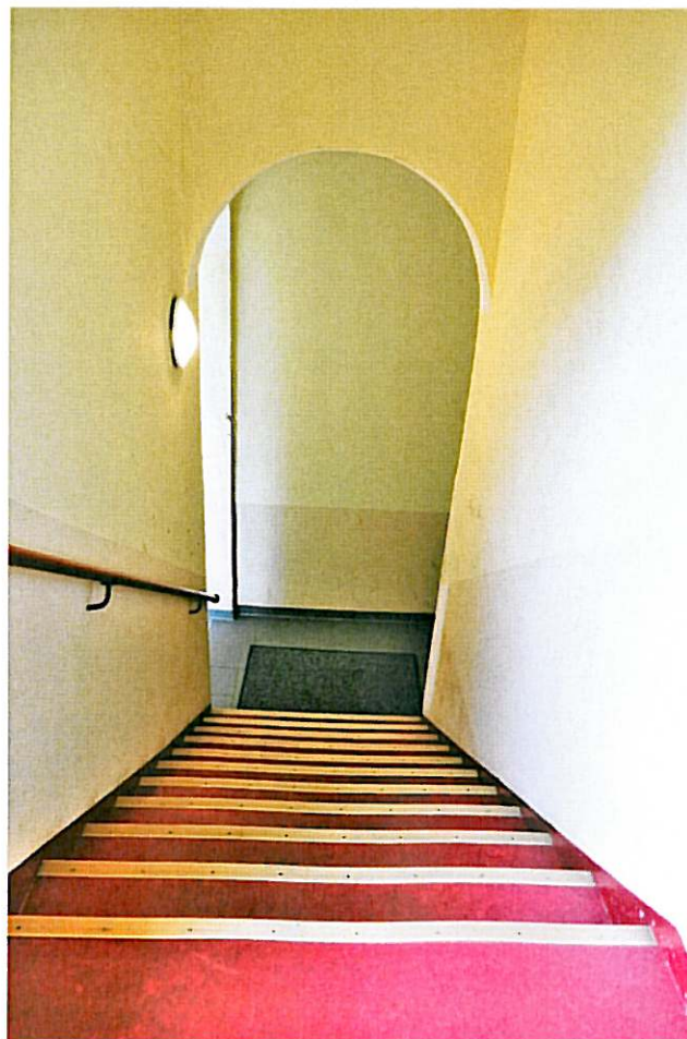
Treppenhaus EG mit Zugang zum Hausdurchgang
