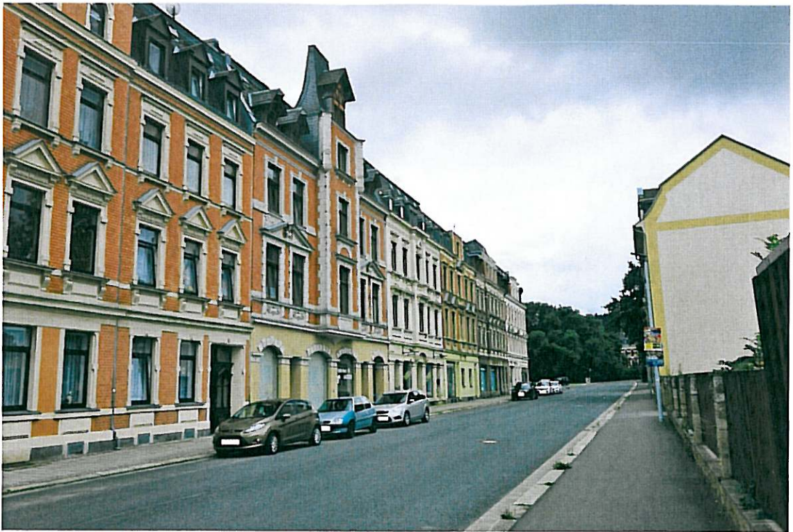
Oelsnitz/Vogtl., Bahnhofstraße 17, Wohn-/Geschäftshaus nebst angrenzender Bebauung, NNO-Ansicht
