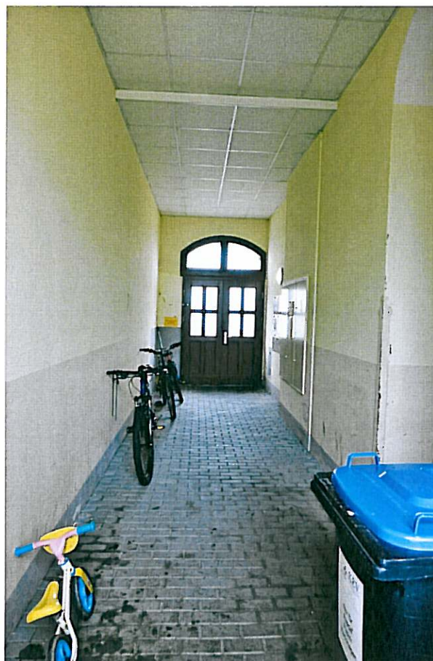
EG, Hausdurchgang mit Holztüre zur Straße und abgehendem Zugang zum Treppenhaus (i. B. rechts)
