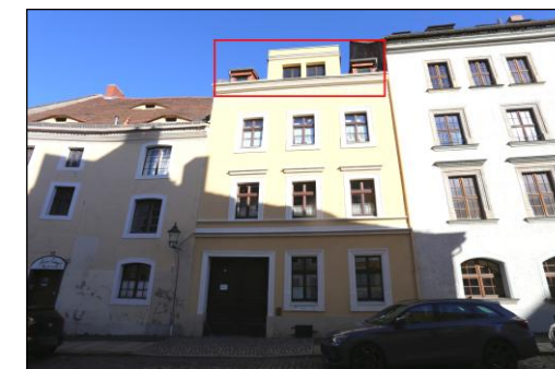
Blick auf die Straßenfassade des Wohnhauses mit Markierung der Wohnung.
