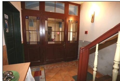
Blick aus dem Treppenhaus auf die Tür zur Hofdurchfahrt.
