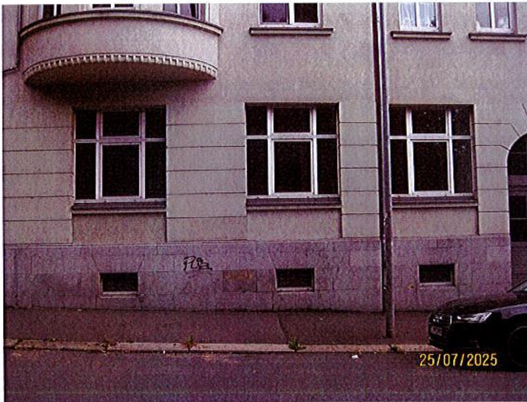
Blick auf Wohnbereich der WE Nr. 3 von außen
