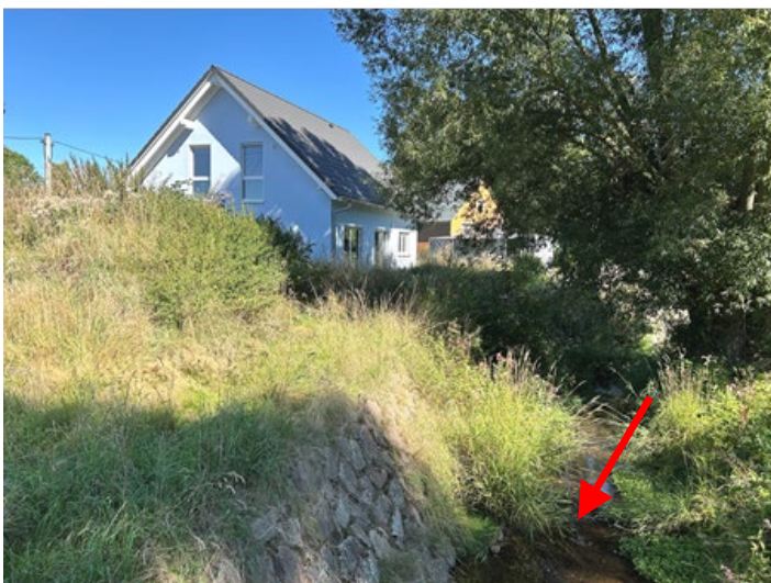
Abb. 04 Ansicht des Grundstücks und Gebäudes aus Richtung Süden mit Bachlauf Kleine Striegis und teilweise Bachmauer an östlicher Grundstücksgrenze
