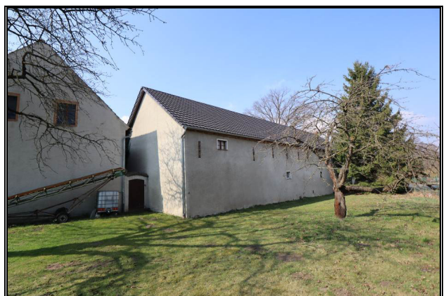
Süd-Ost-Ansicht des Stallgebäudes
