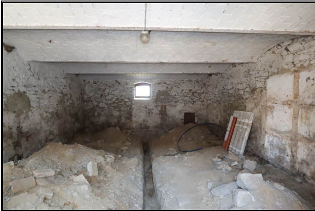
Begonnener Ausbau im Stallgebäude
