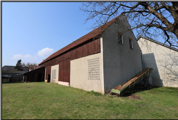
Süd-Ost-Ansicht der Scheune
