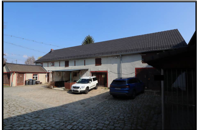
Detailansicht des Vordachs – TG 1
