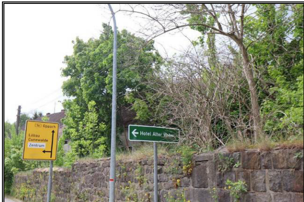
Straßenansicht des ehemaligen Rittergutes mit zu erhaltender Mauer
