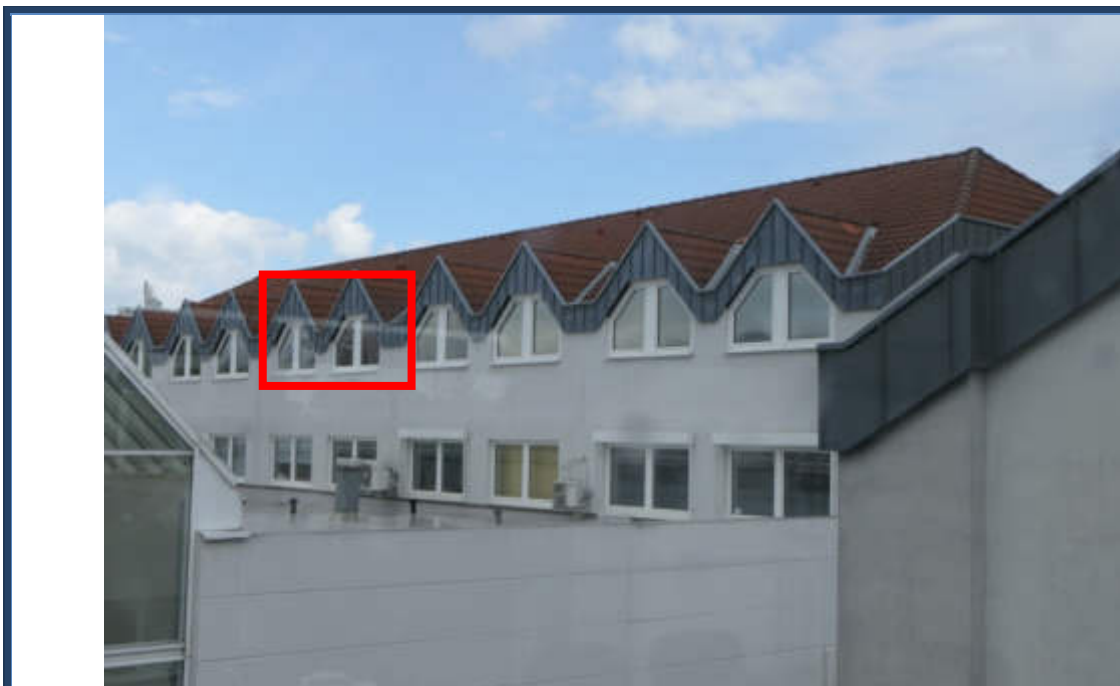
Abbildung 6: Seitenansicht (Ost-Ansicht); Blick vom benachbarten Gebäude auf Flurstück 748/19; Lage der zu bewertenden Gewerbeeinheit Nr. 20
