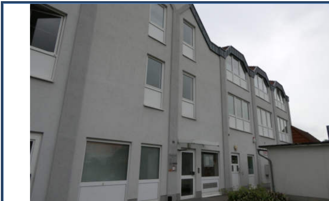
Abbildung 16: Eingangsbereiche an der Gebäudenordseite (u. a. zur Gewerbeinheit Nr. 20)
