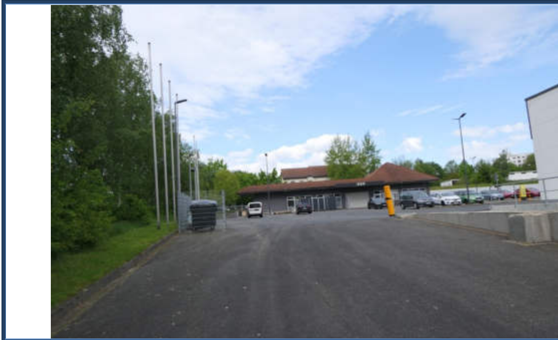
Abbildung 9: Blick in westliche Richtung zu den Parkflächen
