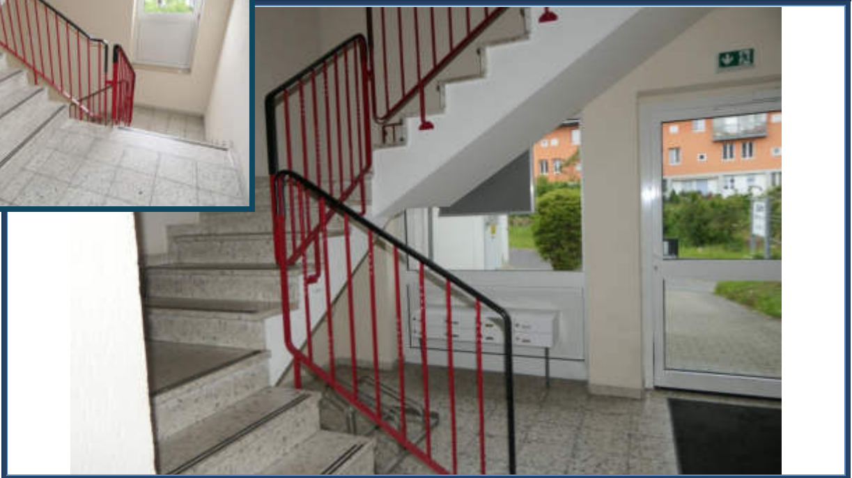
Abbildung 17: Eingangsbereich; Hausflur mit Treppenhaus (Ärztehaus/Bürohaus; Oberer Viebig 2b)
