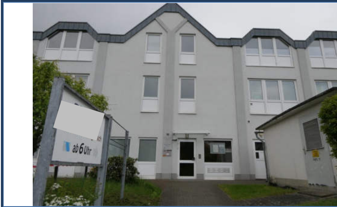
Abbildung 15: Eingangsbereich an der Gebäudenordseite (u. a. zur Gewerbeinheit Nr. 20)
