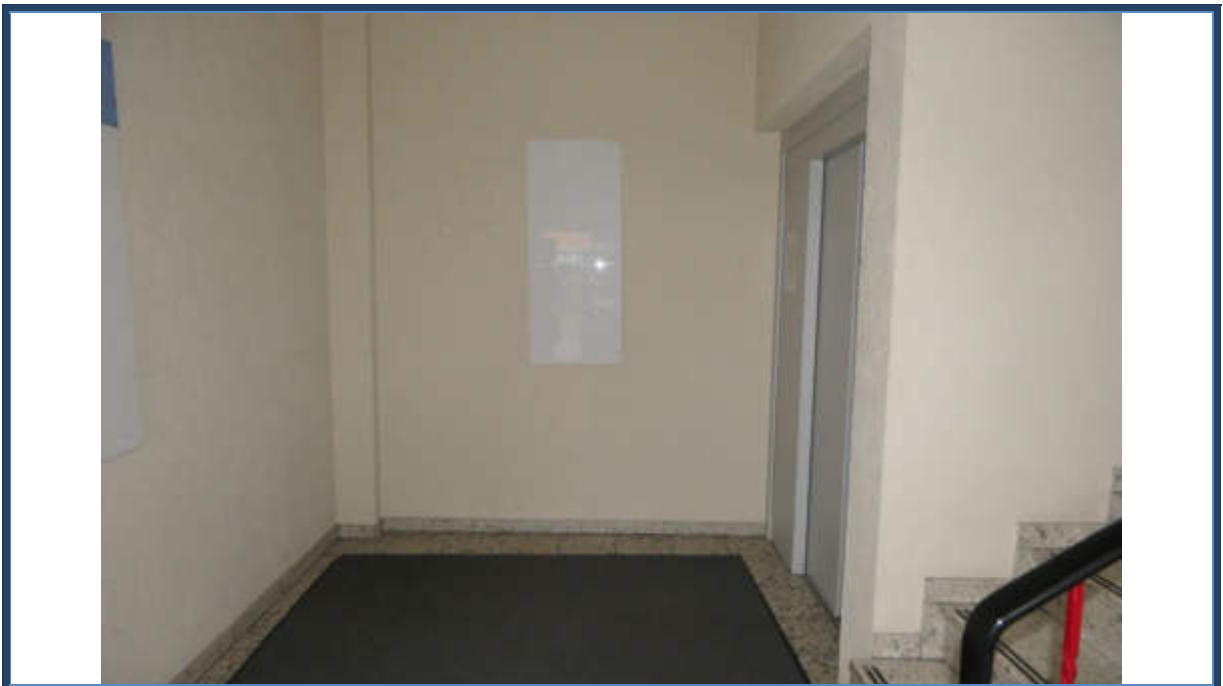
Abbildung 18: Eingangsbereich mit Treppenhaus; Zugang zum Fahrstuhl (Ärztehaus/Bürohaus; Oberer Viebig 2b)
