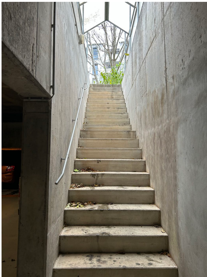
Abb. 12 Ansicht rückwärtiger Tiefgaragenausgang auf die Tiefgaragendachfläche
