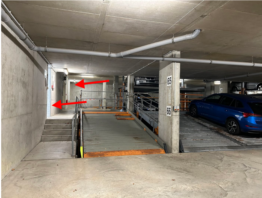
Abb. 11 Teilansicht Tiefgarage mit Ausgängen zu Häusern Tannenstraße 4 und 6
