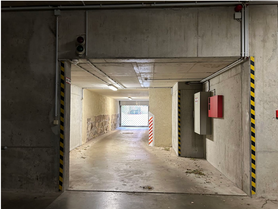
Abb. 07 Ausfahrt aus Tiefgarage Haus Tannenstraße 6
