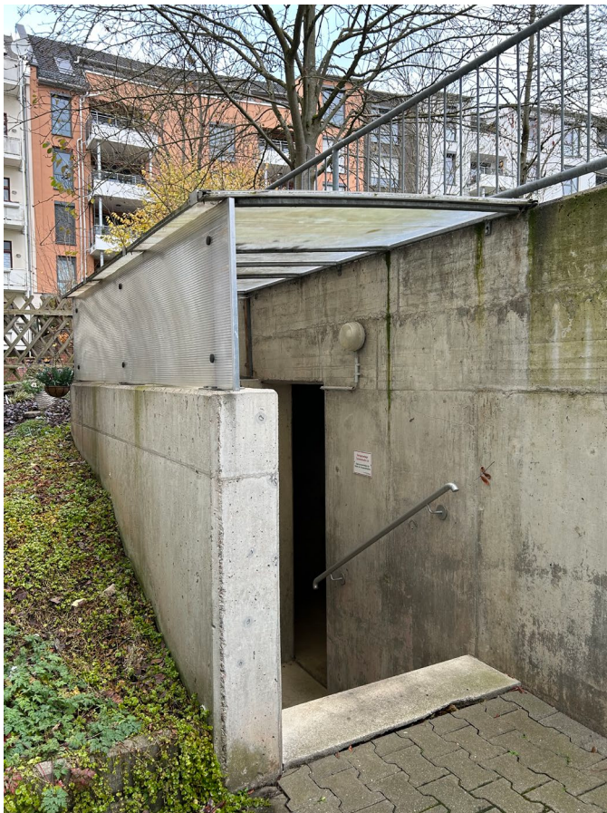
Abb. 09 Zugang zur Tiefgarage über Haus Tannenstraße 6
