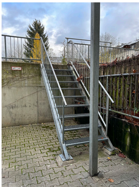
Abb. 10 Zugang zur Dachfläche der Tiefgarage von Grundstück Tannenstraße 6 aus
