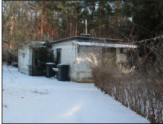
Vorderansicht des großen Nebengebäudes
