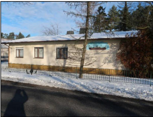
Straßenansicht des Einfamilienhauses
