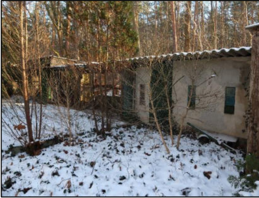
Nebengebäude an der östlichen Grundstücksgrenze
