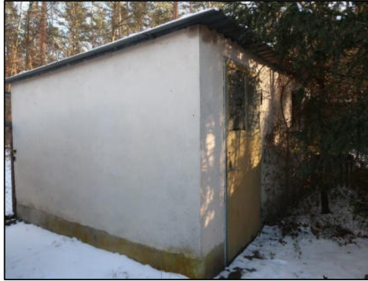
Nebengebäude an der nordöstlichen Grundstücksecke
