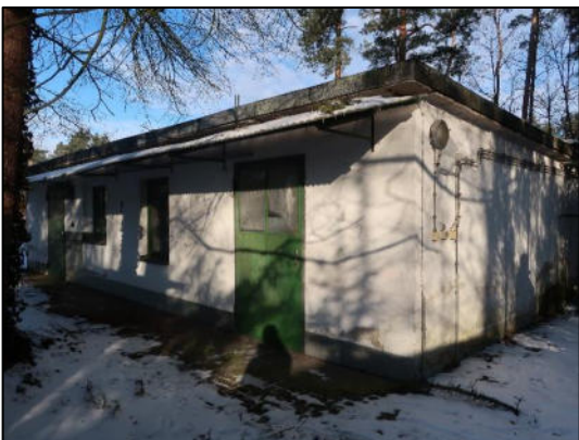
Vorderansicht des großen Nebengebäudes
