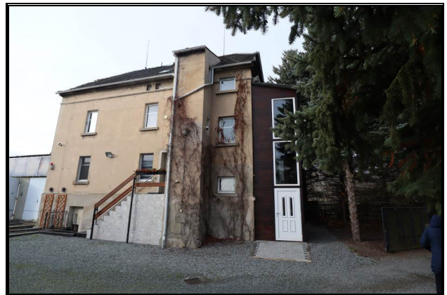
Ost-Ansicht des Wohnhauses mit nachträglich angebautem Aufzug
