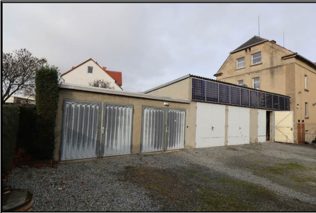
Süd-Ost-Ansicht des Werkstatt- und Garagenbaus
