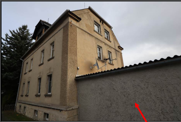
Süd-West-Ansicht des Wohnhauses; Werkstatt- und Garagenanbau
