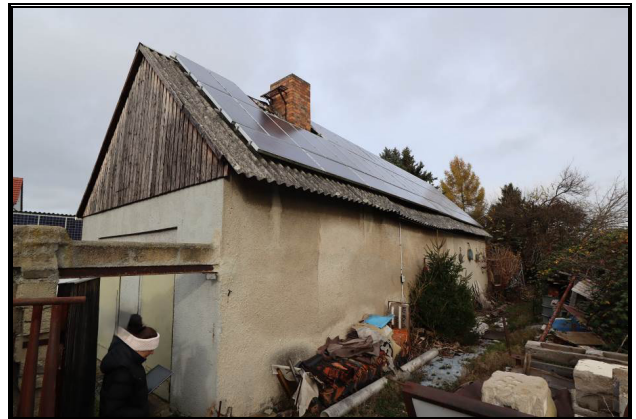
Süd-Ost-Ansicht des ehemaligen Werkstattgebäudes
