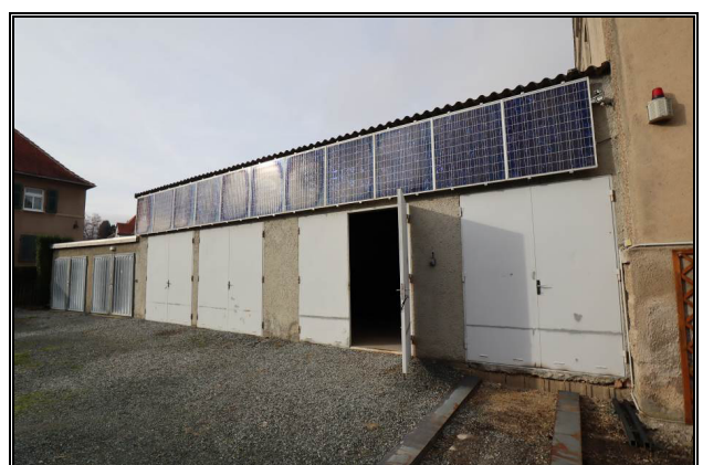
Ost-Ansicht des Werkstatt- und Garagenbaus
