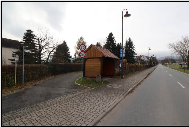
Nord-Ansicht der Buswartehalle auf dem Teilgrundstück 2
