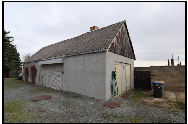
Süd-West-Ansicht des ehemaligen Werkstattgebäudes
